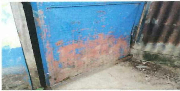
Foto 3: aula No. 3 Sustrucción de puerta
