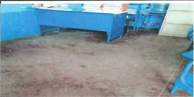
Foto 2: aula No. 2 cambio de piso
