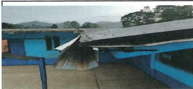
Foto 6: Cambio de canales y bajada pluvial
