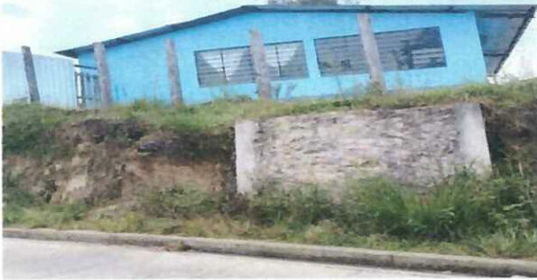
Foto 1: aula No. 01 Sustrucción de muro perimetral
