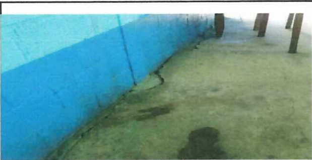
Foto1: aula No. 01 Cambio de Piso
