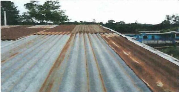
Foto 2: aula No. 2 Cambio de Techo
