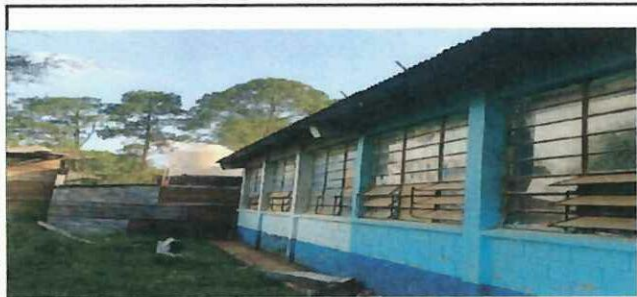
Foto 5: cambio de Canales y bajada pluvial
