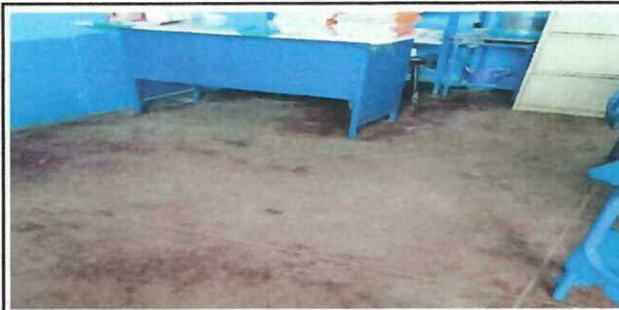
Foto 3: aula No. 3 Cambio de Piso
