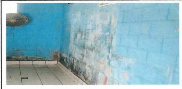
Foto 6: impermeabilizar y pintar pared
