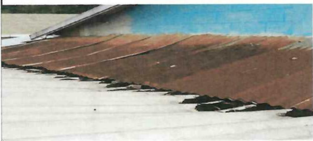
Foto1: aula No. 01 Cambio de Techo
