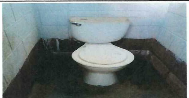
Foto 6: Cambio de sanitario y accesorios
