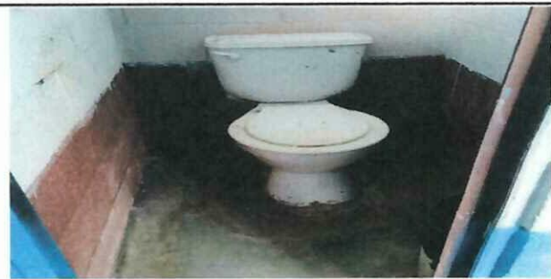
Foto 5: cambio de Sanitario y Accesorios
