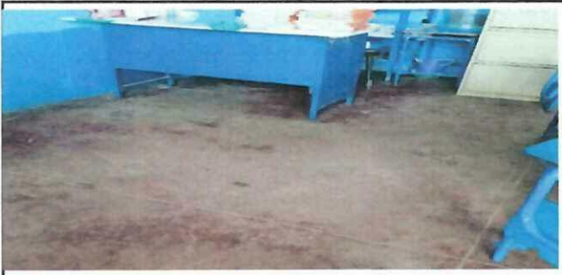
Foto 4: Cambio de Piso
