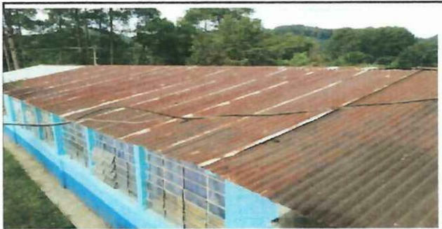
Foto 4: Cambio de techo
