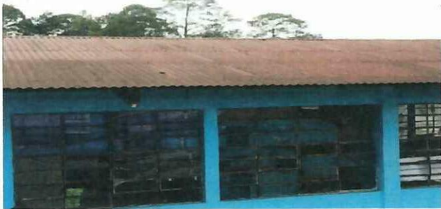
Foto 3: aula No. 3 Cambio de Techo
