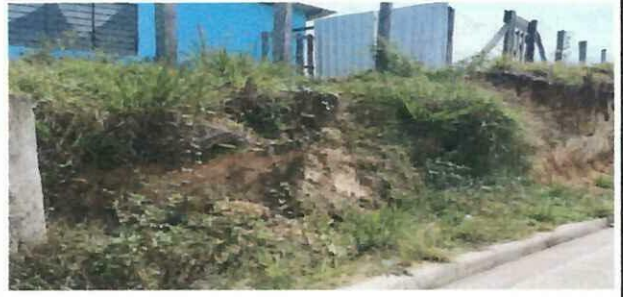
Foto 2: aula No. 2 Sustrucción de muro perimetral
