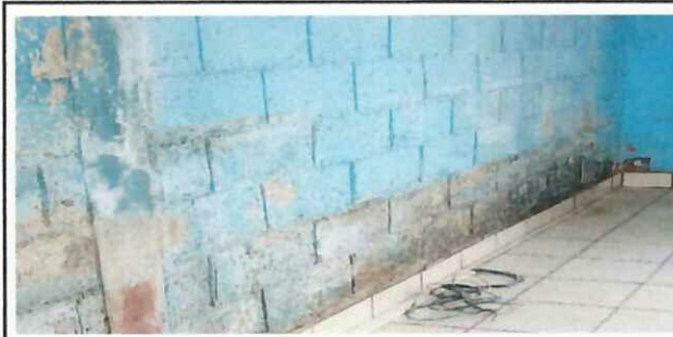
Foto 5: Impermeabilizar y pintar pared
